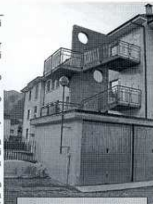
Scala d'emergenza della Scuola Elementare
