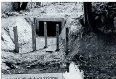
Lavori di sistemazione idraulica a Tetti Frega.
